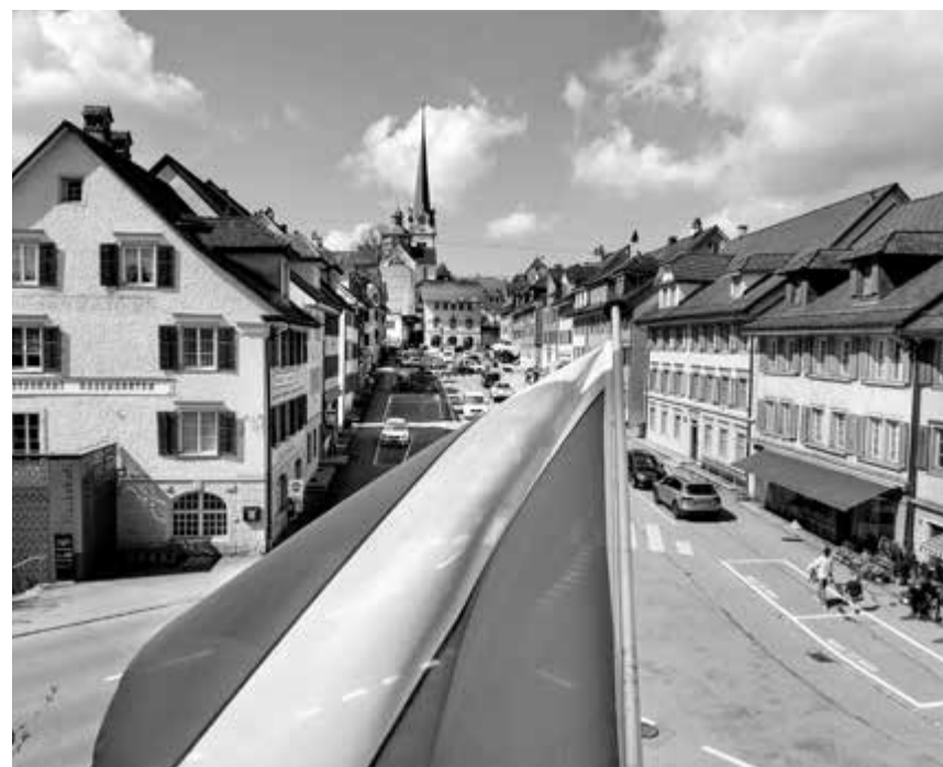
Hier im «Fläcke» wird im Sommer 2027 das Abwasser-Trennsystem eingeführt.
