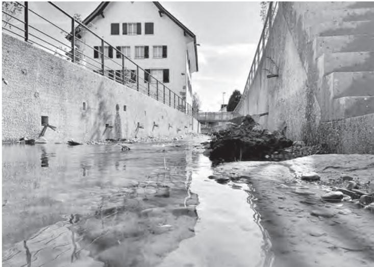
Die baufälligen Ufermauern wurden durch neue ersetzt.
