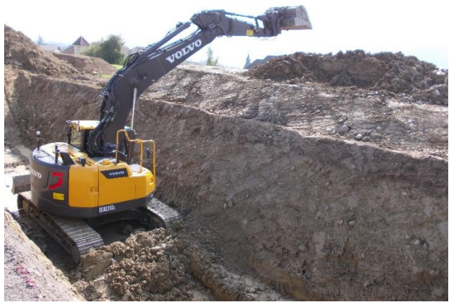
Ein Bagger hebt Aushubmaterial aus
