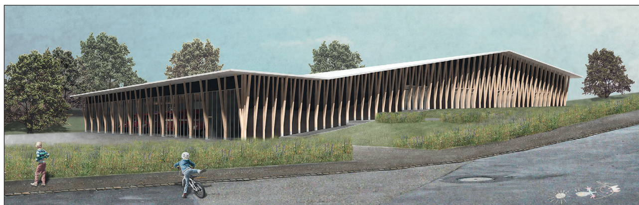
Blick ab Einmünder Hauptstrasse Gunzwil zum Grasweg.
