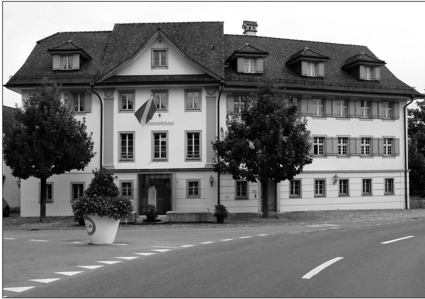
Die Fassade des Gemeindehauses wird bald saniert.
